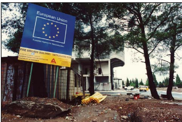
Konstruktionsarbejde på en brandstation - Podgorica (Serbien og Montenegro) © EC/A. Zrno
