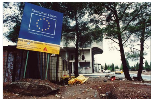
Egy tűzoltósági épület építési munkálatai – Podgorica (Szerbia és Montenegró) © EC/A. Zrno
